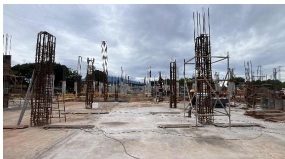
Ilustración 9. Avance de obra chaparral
