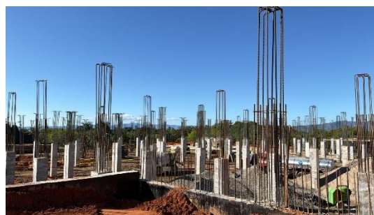
Ilustración 10. Avance de obra chaparral
