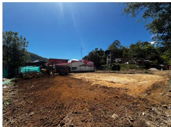
Ilustración 12. Avance de obra rioblanco
