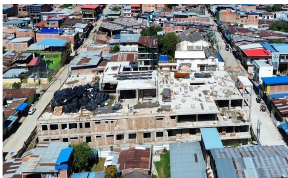
Ilustración 7. Avance de obra planadas
